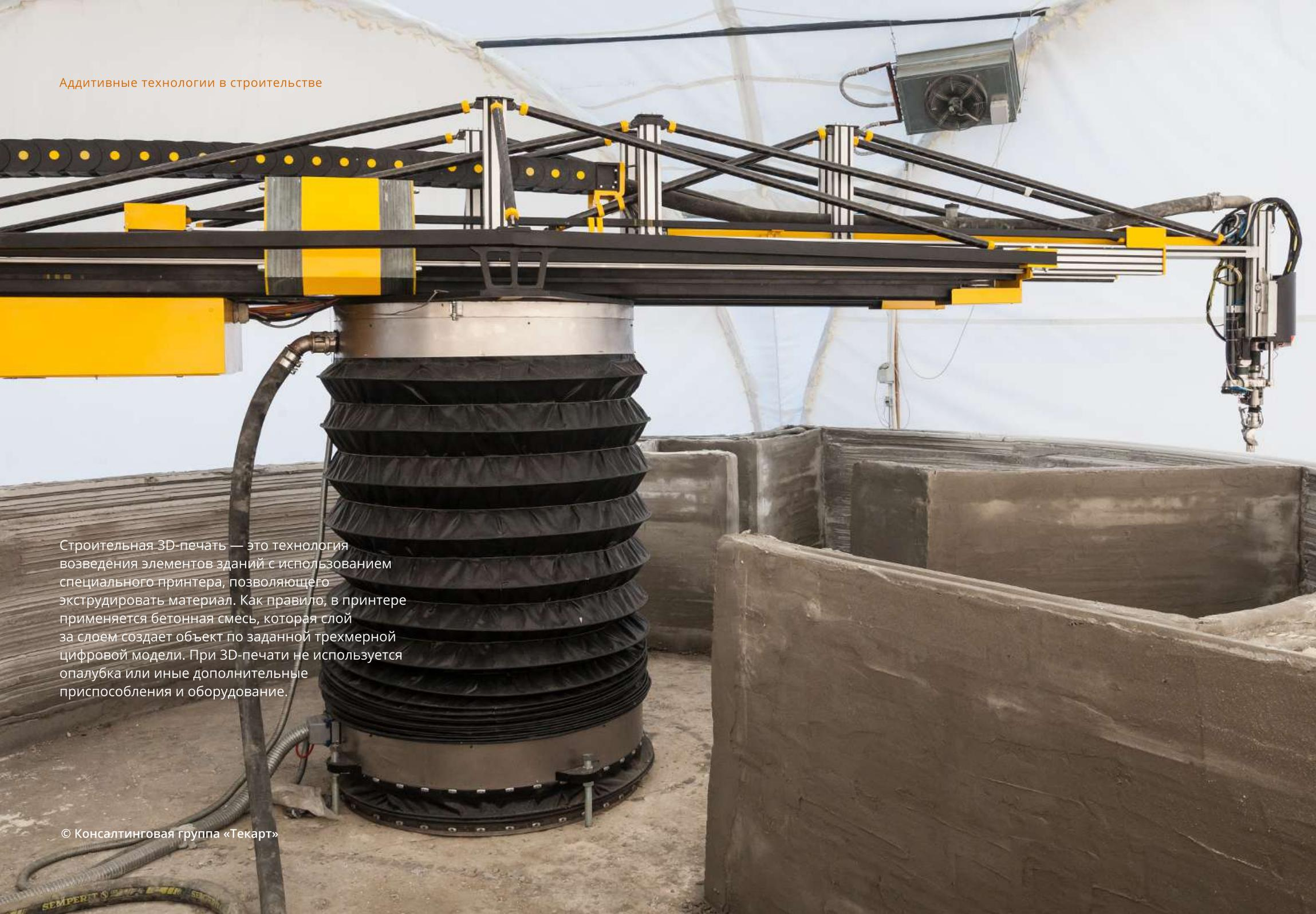
Строительная 3D-печать — это технология возведения элементов зданий с использованием специального принтера, позволяющего экструдировать материал. Как правило, в принтере применяется бетонная смесь, которая слой за слоем создает объект по заданной трехмерной цифровой модели. При 3D-печати не используется опалубка или иные дополнительные приспособления и оборудование.
