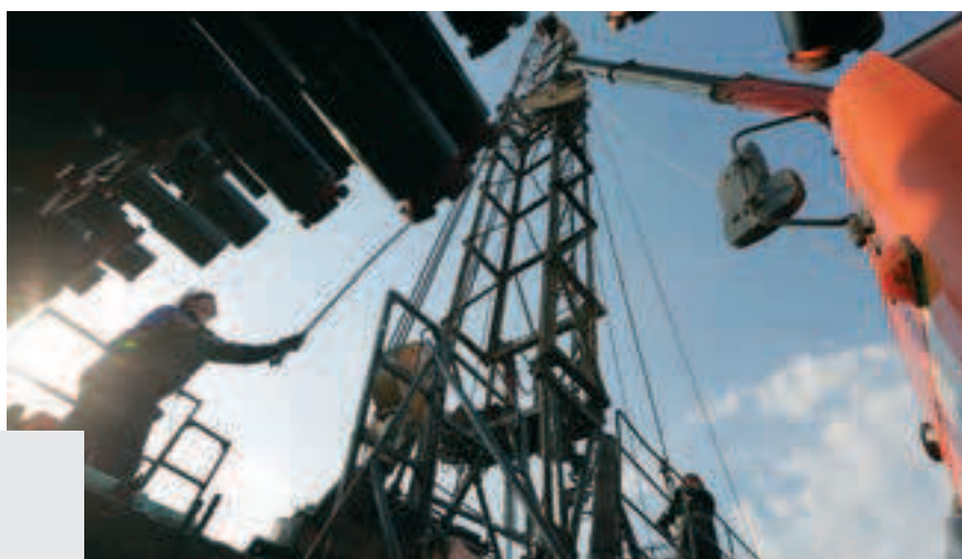
УЭЦН группы «Римера» монтируется на скважине в Поволжье
